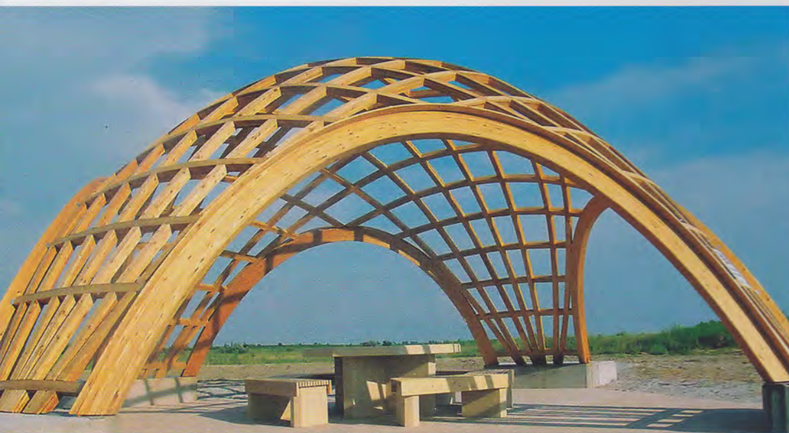
Der Radius war gewagt: Denn es gab viel Bruch bei dem Versuch, die Hölzer in die gewünschte Form zu biegen.
