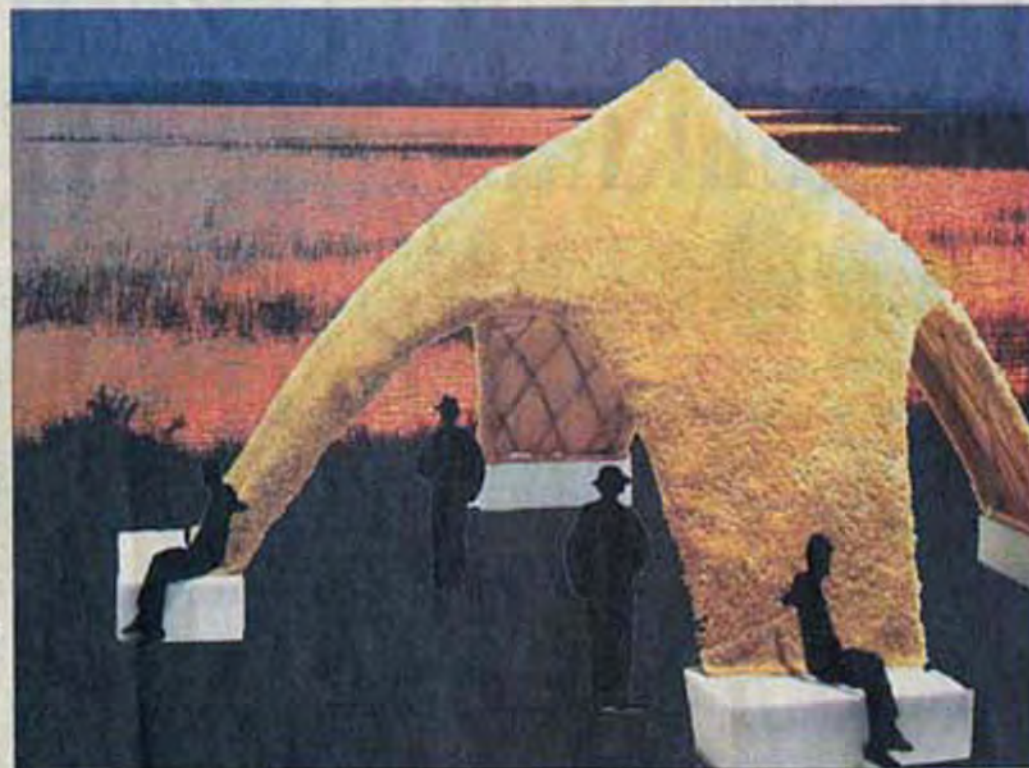
Schilfbedeckte Holzlatten (1,5 km) ergeben die Holzgitterschale.
