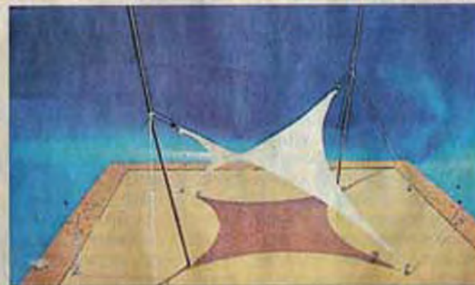
Das Sonnensegel: Jedes der vier Edelstahl-Seile hält einer Zugkraft von neun Tonnen stand.
